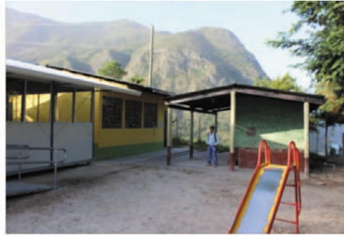
Fotografía No.31 Escuela actual de Río Negro
