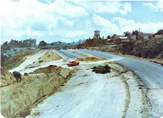
Construcción del Anillo Periférico. Fuente: Municipalidad de Guatemala, 1974.
