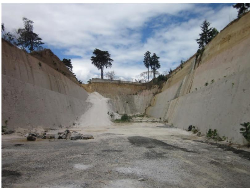
**Nota:** puede observarse el considerable movimiento de tierra que se requirió para el trazo de esta sección del libramiento, así como el “tope” al final de la misma en donde se ubicaba una propiedad que aún no había sido adquirida por parte del Estado para la continuación de esta obra. Fuente: el autor. 2018.
